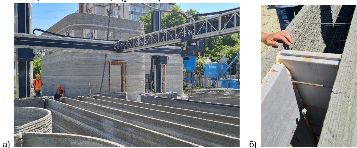
Рис.1. Друкування корпусу школи за допомогою 3D принтеру: а) загальний вигляд будівництва, б) вигляд стіни.
